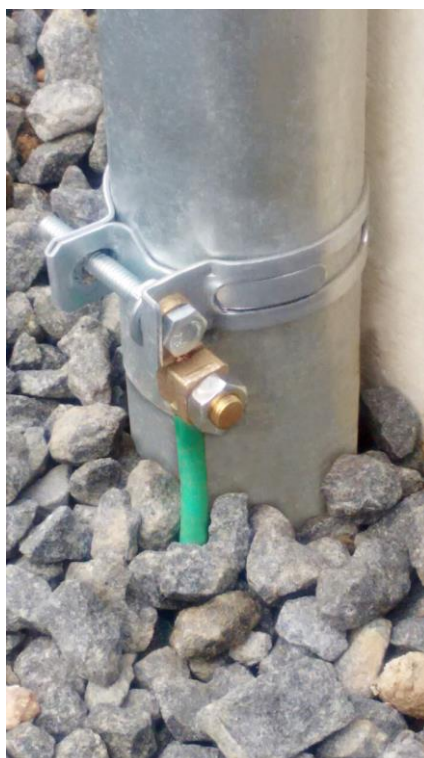
Foto ilustrativa 02 dos anexos D, E, H e I – Detalhe da abraçadeira com terminal para aterramento
