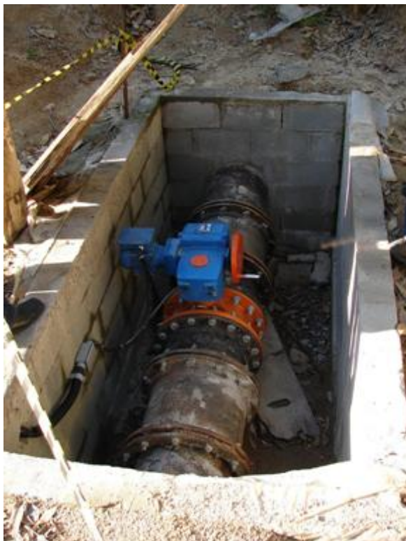
Figura 43 Instalação da válvula telecomandada no Reservatório R-2
