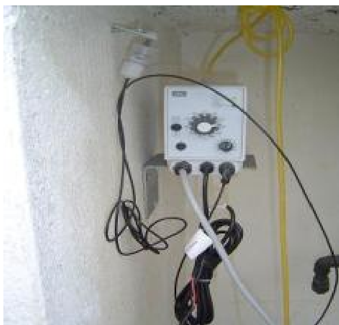
Figura 28 Foto Dosador de Peróxido de Hidrogênio (à direita)
