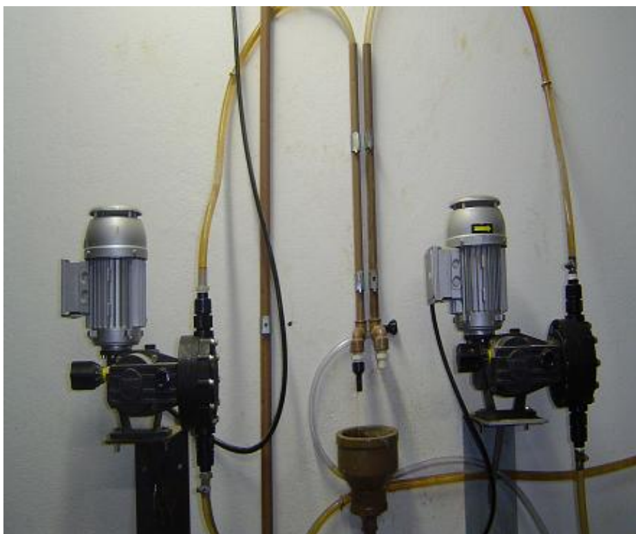
Figura 37 Foto Dosadores de Poliortofosfato
