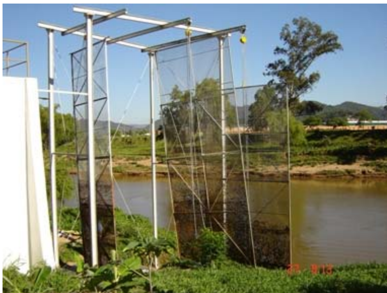
Figura 16 Telas para retenção de sólidos
