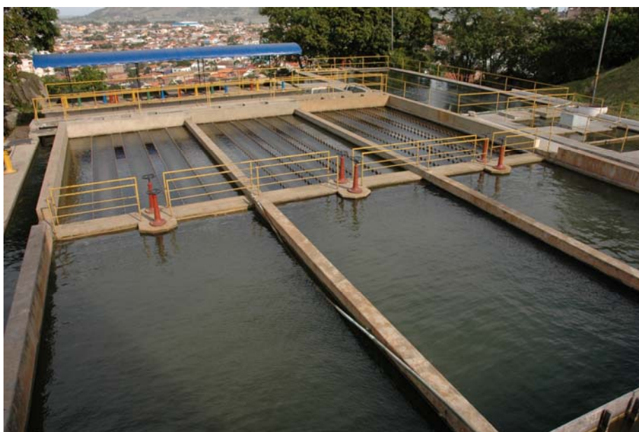
Figura 33 Foto Decantadores mistos
