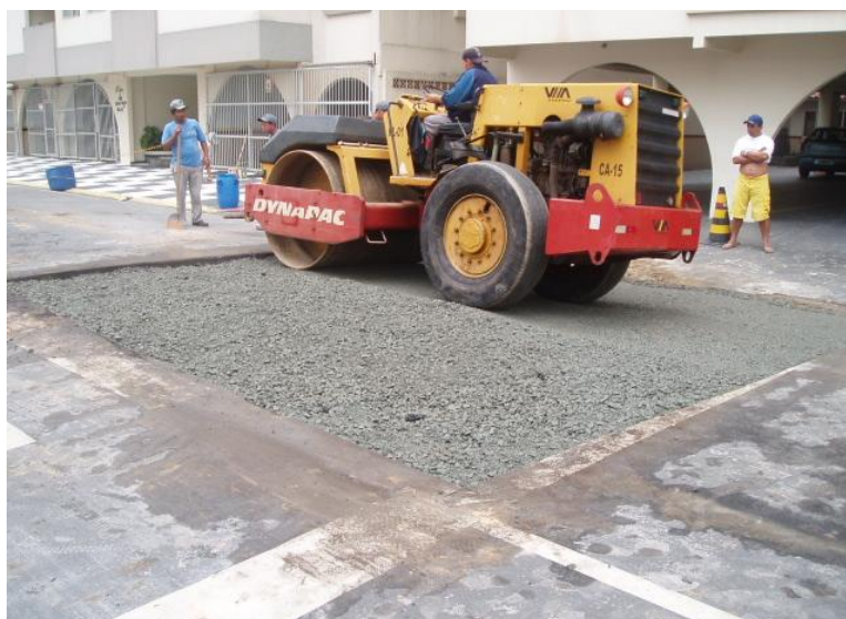
Figura 70 Compactação da Base de Brita Graduada a 100% PN
