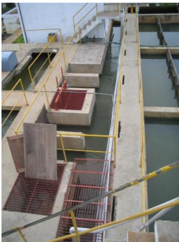
Figura 32 Foto canal de água floculada
