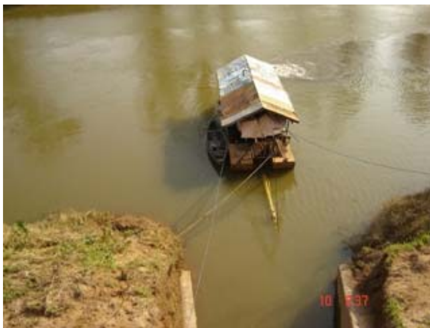
Figura 17 Dragagem do canal de entrada da água bruta no sistema de captação
