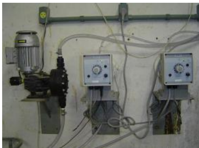
Figura 27 Foto Dosadores de Hidróxido de Sódio (à esquerda)
