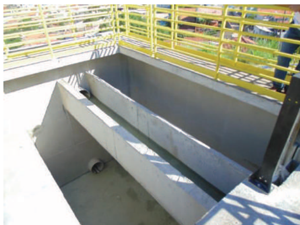
Estrutura dos Filtros aguardando leito filtrante e instalação de fundo falso
