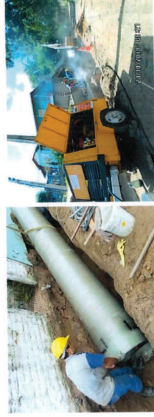
Fotos 03 e 04 – Assentamento de adutora DN700mm com desmonte de rocha.
