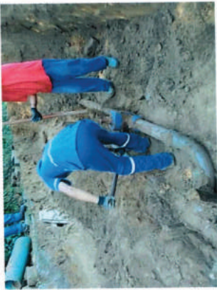
Foto 02 – Execução de By-pass
