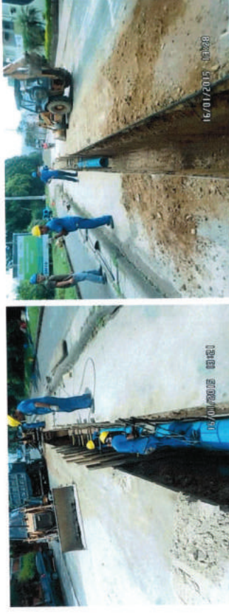
Fotos 01 e 02 – Assentamento de adutora DN 500mm no Bairro Dehon.
