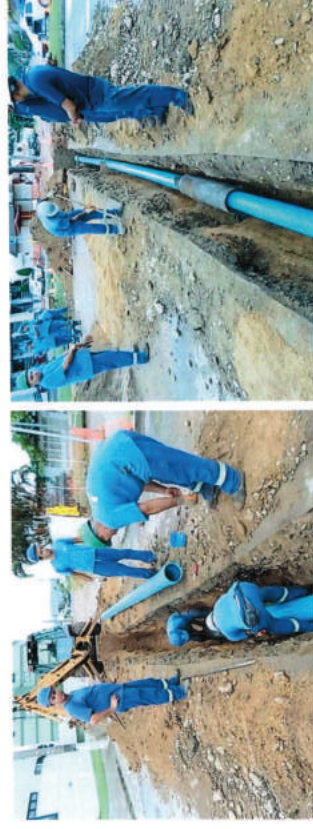
Fotos 09 e 10 – Assentamento de rede DN 150mm no bairro Vila Moema
