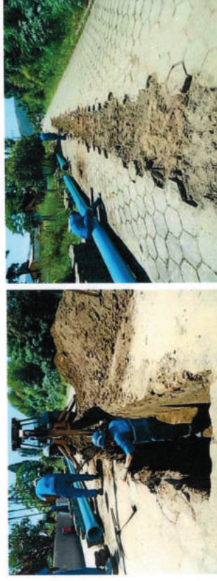
Fotos 03 e 04 – Assentamento de rede DN 300mm no bairro São João margem direita.
