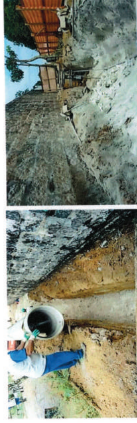
Fotos 01 e 02 – Assentamento de adutora DN600mm com desmonte de rocha.
