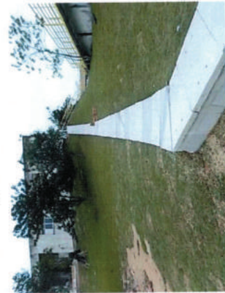
Foto 01 – Canaleta de distribuição de energia
