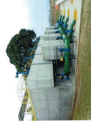
Foto 01 – Tubulação e válvulas de saída
