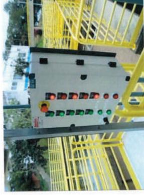
Foto 04 – Painel de automação
