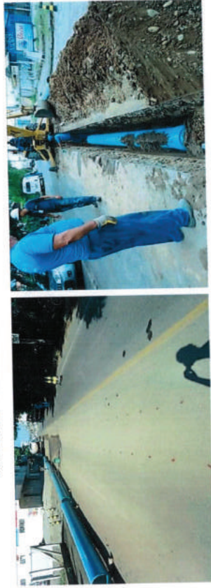
Foto 03 e 04 – Assentamento de adutora de DN 400mm no bairro Revoredo.
