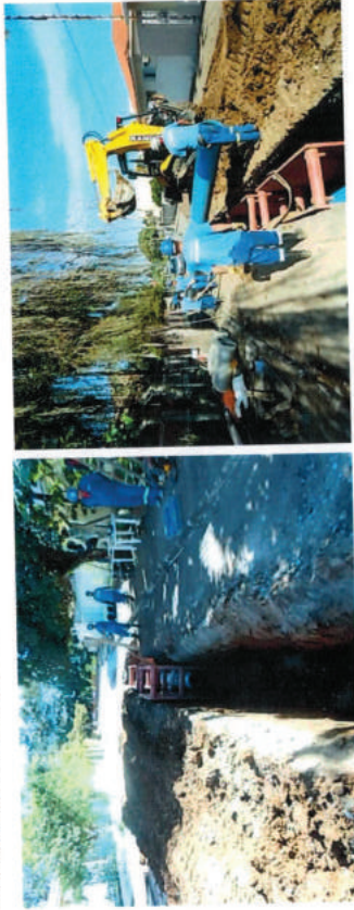
Foto 01 e 02 – Assentamento de adutora de DN 400mm no bairro Passagem.
