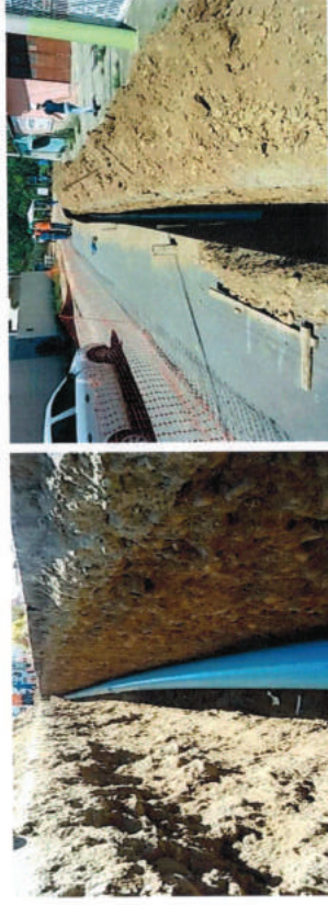
Fotos 07 e 08 – Assentamento de rede DN 200mm no bairro Passagem
